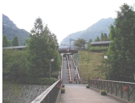
樹木による法面緑化
