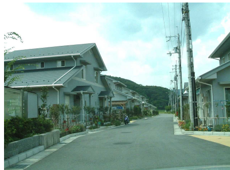
植栽空間を確保した宅地
