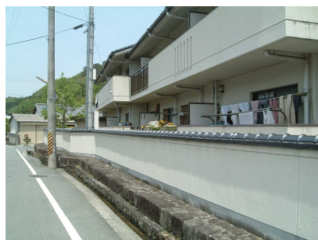
町並みに配慮した塀の設置
