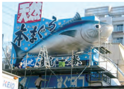
▼ 景観に配慮が望まれる事例
