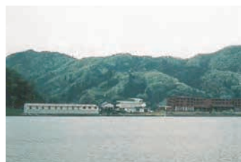
▼ 景観に配慮が望まれる事例
