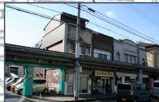
④旧5軒長屋 当初は5軒あったRC造2階建の3軒長屋。除却された2軒のRC造の柱や梁が今でも残る。
