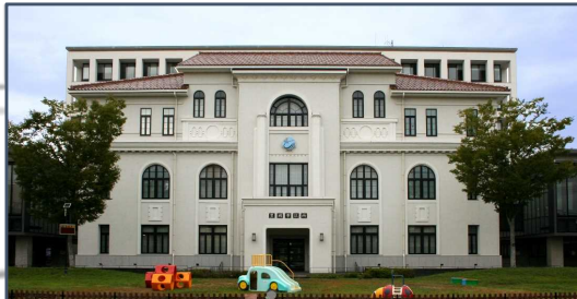
①旧豊岡町役場庁舎 （国登録有形文化財） 昭和2年度にRC造2階建の豊岡町役場として建設され、その後3階部分の増築、平成23年度に保存活動により曳家で移動。現在は議場・交流センターとして活用され、震災復興のシンボルとして親しまれている。
