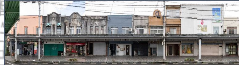
⑤大開通南側長屋 復興期に建築された最も大きな長屋で、大開通りに面する部分をRC造とすることで、都市の防火帯として機能している。また、一部に残るモルタル塗りの外観は建設当初の面影と時代の経過を感じさせる景観となっている。
