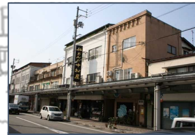
⑦河見家住宅 RC造3階建の店舗併用の長屋住宅で、当初の陸屋根の外観が残る。
