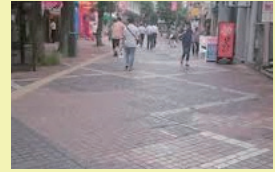
【景観を損ねる舗装事例】
