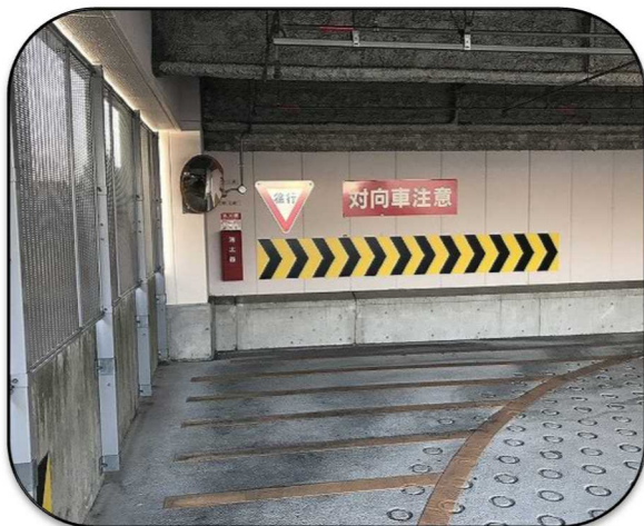
カーブミラーの設置
