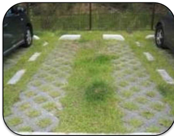
保護材による車輪部の補強
