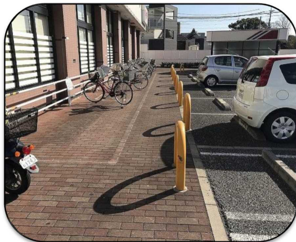
防護柵の設置
