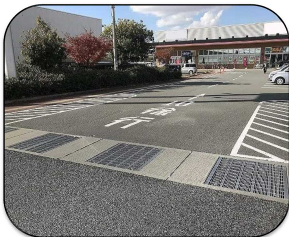
路面標示による注意喚起
