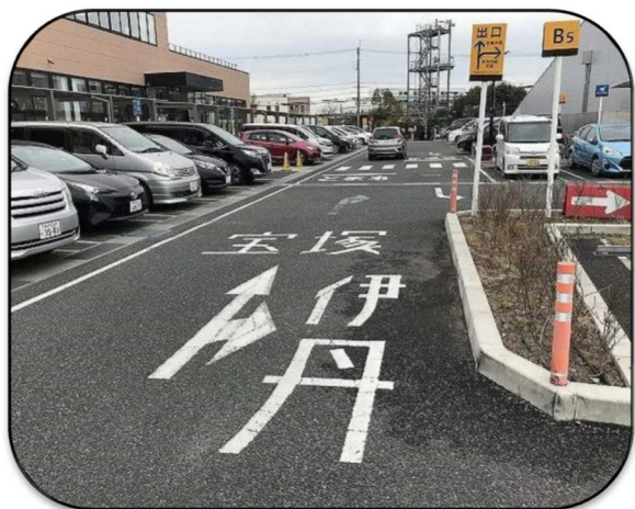
方面別に出口を誘導する路面標示
