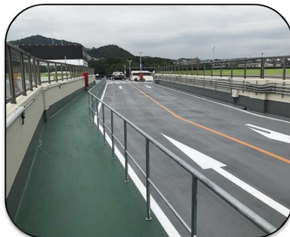
歩車分離された建物間の連絡通路
