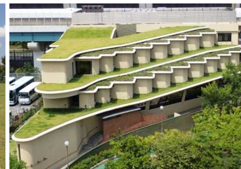
屋上緑化（芦屋市）
