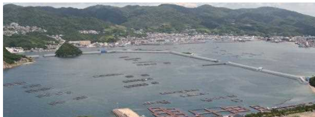
湾口防波堤の整備(南あわじ市)
