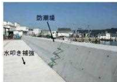
福良港の防潮堤(南あわじ市)
