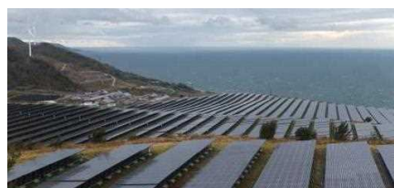
太陽光発電施設(淡路市)
