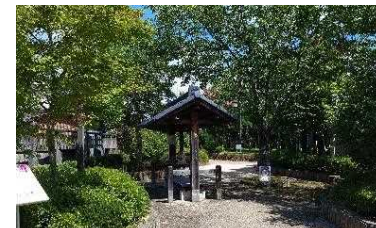
延焼防止性能を有する公園(丹波篠山市)
