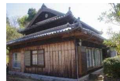
空家を多自然居住交流拠点施設に改修(洲本市)
