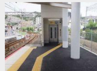
鉄道駅舎のエレベーター設置（神戸市）
