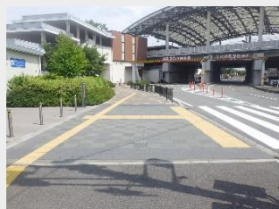
歩道のバリアフリー化（西宮市）
