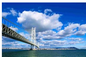
明石海峡大橋(淡路市)
