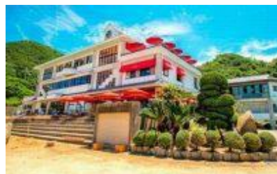
廃校を活用した複合観光施設(淡路市)
