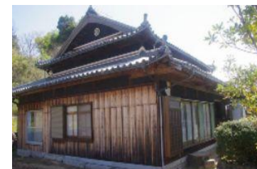
空き家を多自然居住交流拠点施設に改修(洲本市)
