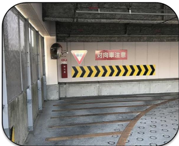
カーブミラーの設置
