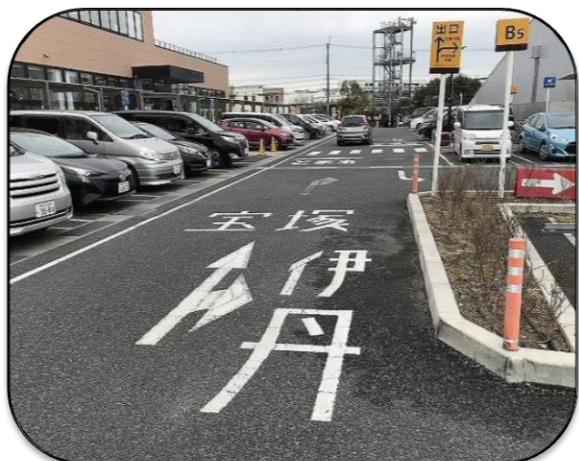
方面別に出口を誘導する路面標示
