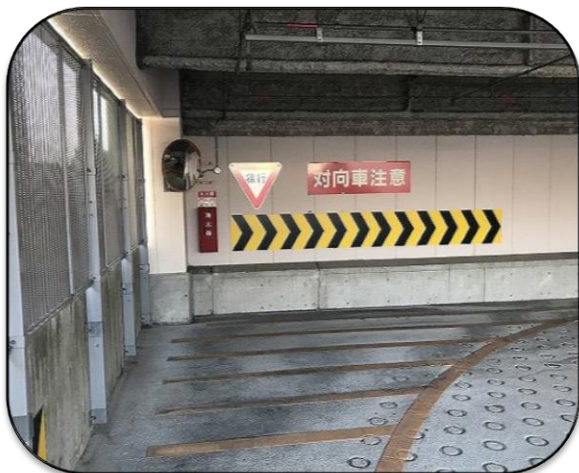
カーブミラーの設置
