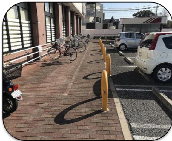
防護柵の設置
