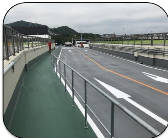
歩車分離された建物間の連絡通路
