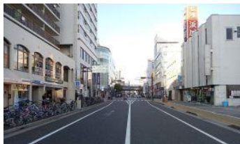
無電柱化整備状況(伊丹市)
