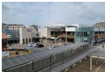
JR土山駅前の都市型商業施設(播磨町)
