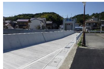
福良港の防潮堤(南あわじ市)
