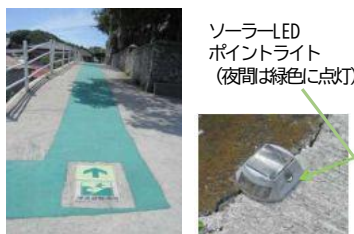
避難路のカラー舗装(南あわじ市)
