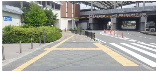
歩道のバリアフリー化(西宮市)
