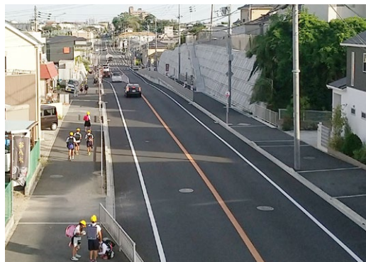
朝霧二見線(明石市)
