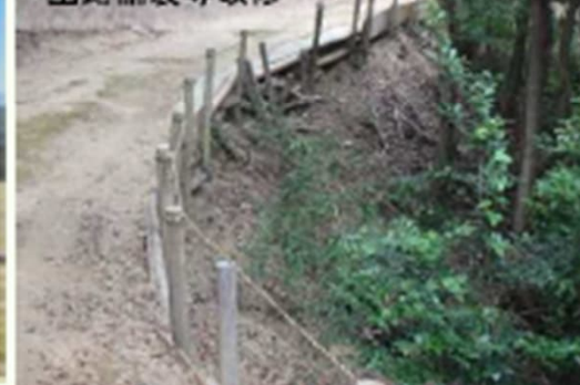
園路舗装等改修
