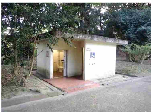
撤去・新設予定のトイレ
