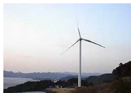
風力発電施設の設置例
