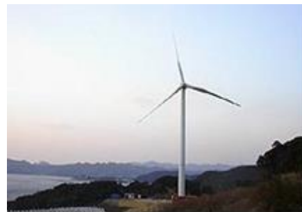
【風力発電施設の設置例】
