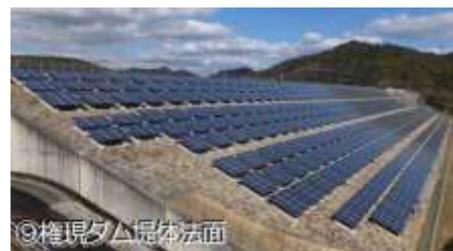
ダム堤体設置の太陽電池モジュール
