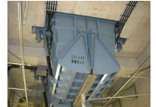
スクリーンかす・沈砂貯留ホッパ
