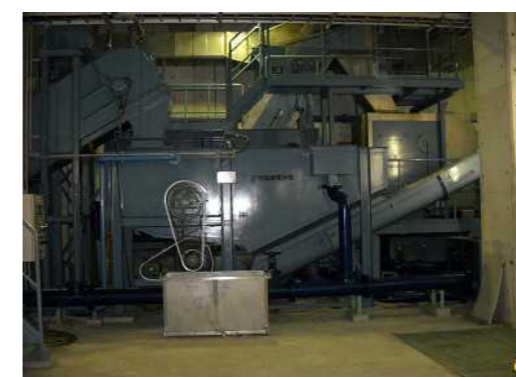
沈砂洗浄搬出機
