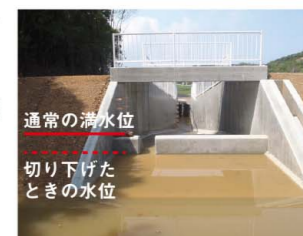
▲洪水吐に一部スリット(切り欠き)を設置
