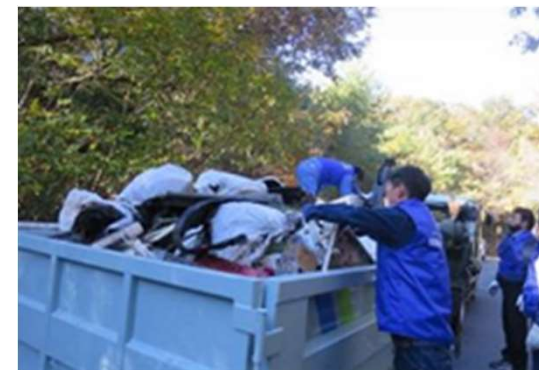
不法投棄物撤去作業の様子（小野市）
