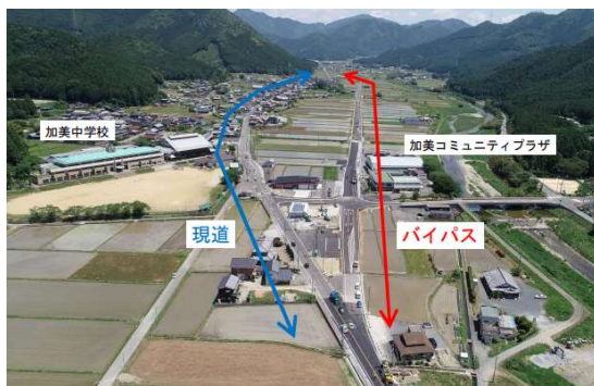
BP供用により現道の歩行者・自転車の安全を確保 豊部BP（多可町）
