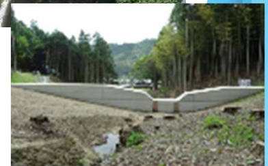
(上)改修されたため池(手前2箇所) (下)集落を守る治山ダム
