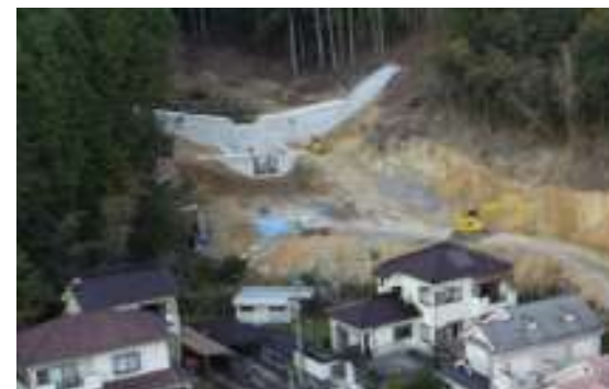
土石流から人命を守る 畑谷2川 砂防堰堤（加西市）
