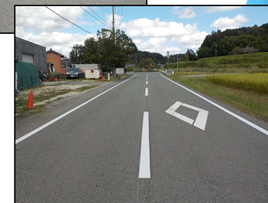
県道下相野森線 道路区画線の引き直し（加東市）
