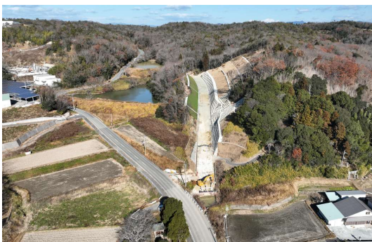
工事が進む 桃坂BP（三木市～加東市）
