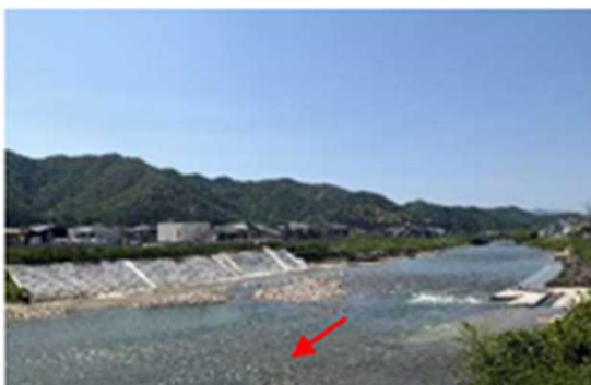
固定取水堰を改築して流下能力が大幅に向上した 杉原川（西脇市）
