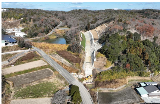
工事が進む 桃坂BP（三木市～加東市）
