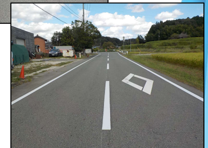
県道下相野森線 道路区画線の引き直し（加東市）
