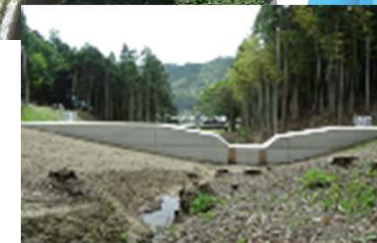
(上)改修されたため池(手前2箇所) (下)集落を守る治山ダム
