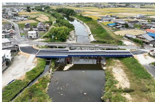
工事が進む 東条川 誉田橋架替（小野市）
