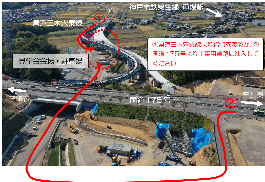
( (仮称)国道175号ランプ工事現場 航空写真(案内) )
