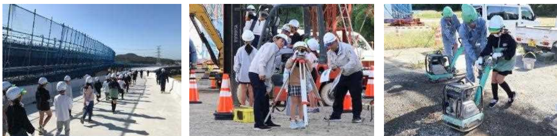
(参考) R5. 10. 12 開催の見学会の様子 ((仮称)国道175号ランプ橋 工事現場)
