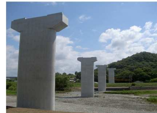
美囊川橋 下部工（三木市別所町）
