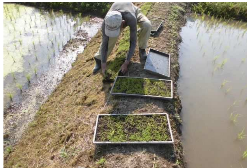
自家製張芝の敷設作業
