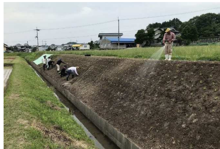
移植直後の散水状況
