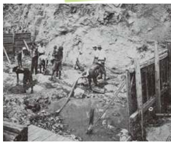
基礎岩盤処理の様子 当時は多くの人力で慎重にすすめられました
