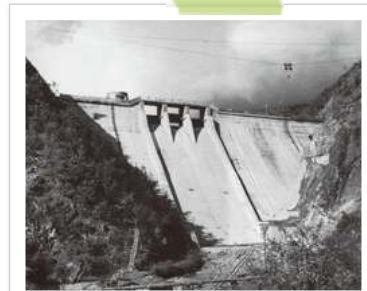
完成直後の鴨川ダム
