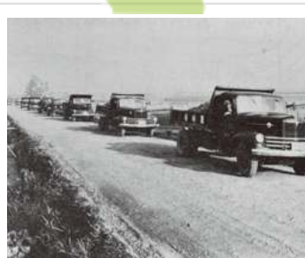
骨材運搬の様子 砂利運搬用の農林省(当時)特製のダンプカーによって加古川より採取され15kmの道のりを運んで運搬しました
