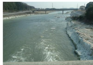
(一) 加古川(河川改修)(西脇市)
