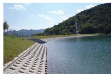
富吉新大池(ため池整備)(西脇市)
