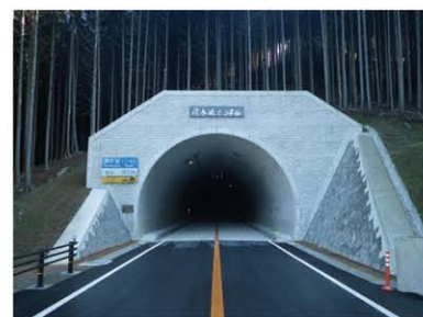
(主)丹波加美線(清水坂トンネル)(多可町)
