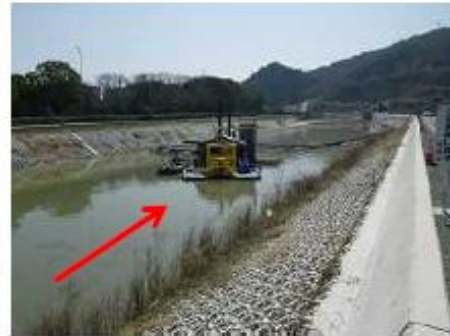
河床掘削工事 施工状況
