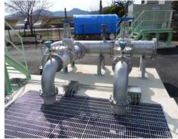
⑤福地雨水ポンプ場建設 (ポンプ \phi 250\text{mm} \times 2 台 約15 \text{m}^3/\text{分} 水槽 約20 \text{m}^3 (3.0 \text{m} \times 4.2\text{m} \times 1.6\text{m} )
