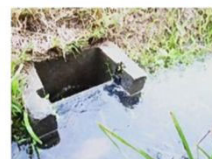
一次的に水位が上がり、せき板を越流し排水
