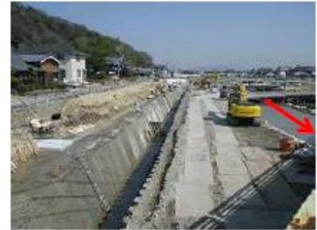
護岸工事 施工状況
