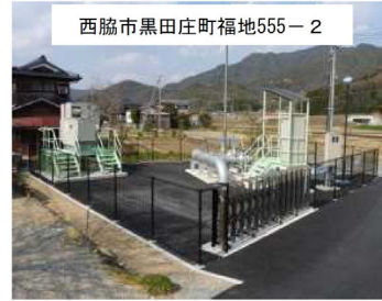
⑤福地雨水ポンプ場建設 (ポンプ \phi 250\text{mm} \times 2 台 約15 \text{m}^3/\text{分} 水槽 約20 \text{m}^3 (3.0 \text{m} \times 4.2\text{m} \times 1.6\text{m} )
