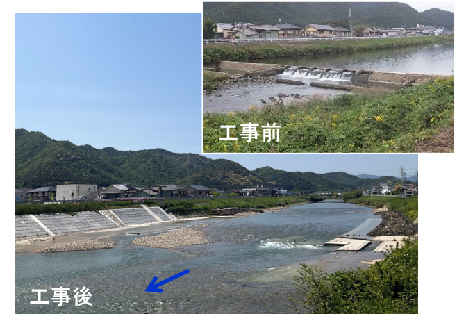
和田井堰 (R5.6状況)
