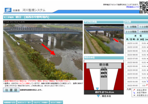
兵庫県 河川監視システム
