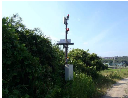
やすらぎの景観警報装置 東条川小野市（小野・加東ブロック）
