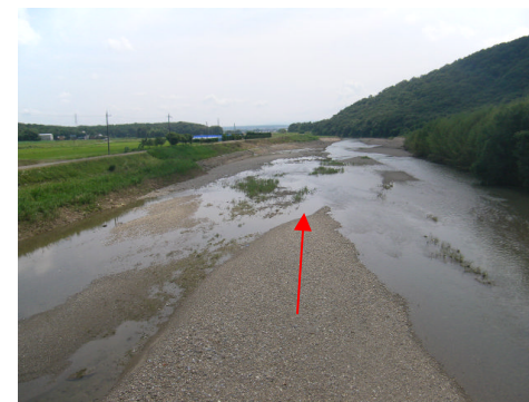
堆積土砂撤去後
