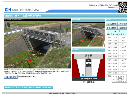
兵庫県 河川監視システム
