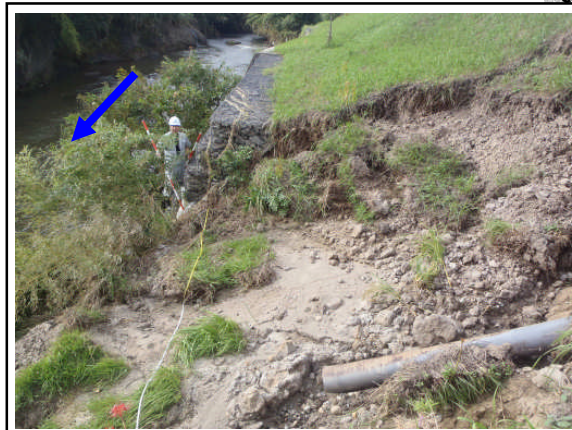
護岸の被災 (美囊川 三木市細川町桃津)
