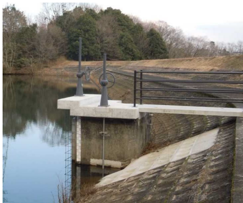
【ため池：オリフィスの改良工事】
