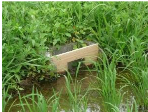
【田んぼダム：田んぼダム用堰板の設置】
