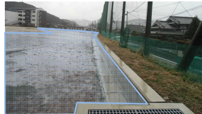
【市立学校： 周囲小堤、側溝、余水吐、オリフィス柵の整備】
