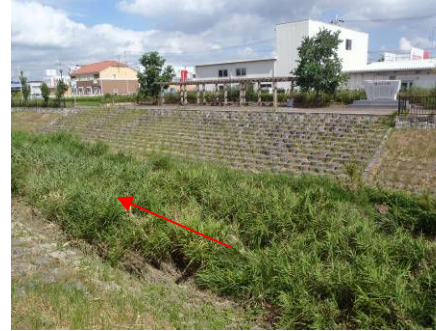
階段護岸の整備 (金剛寺谷川)
