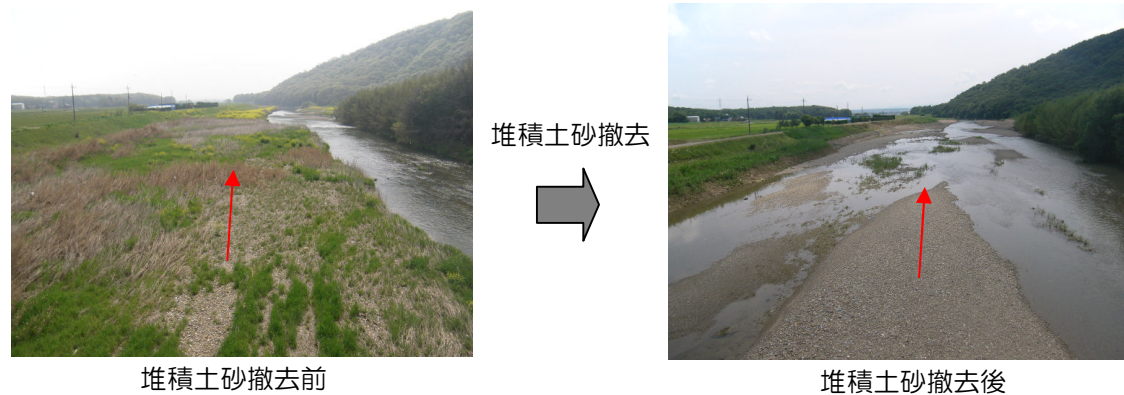
堆積土砂撤去による河道の維持(万願寺川)
