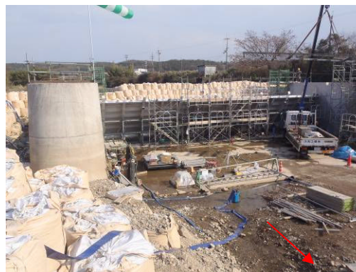
六ヶ井堰(東条川) 改築状況
