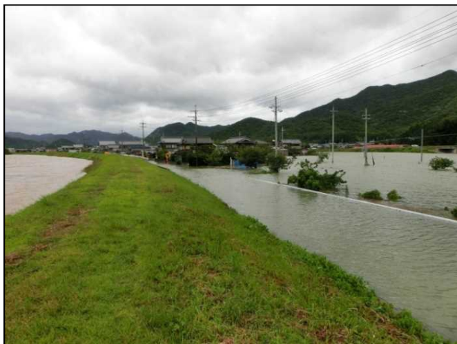
平成25年台風第18号の浸水状況
