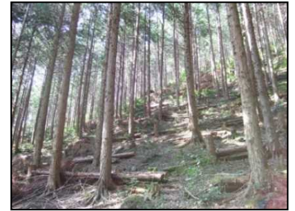
緊急防災林整備(土留工) [丹波市]
