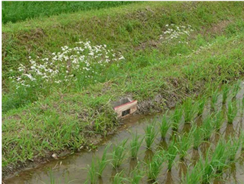
【田んぼダムセキ板設置状況】
