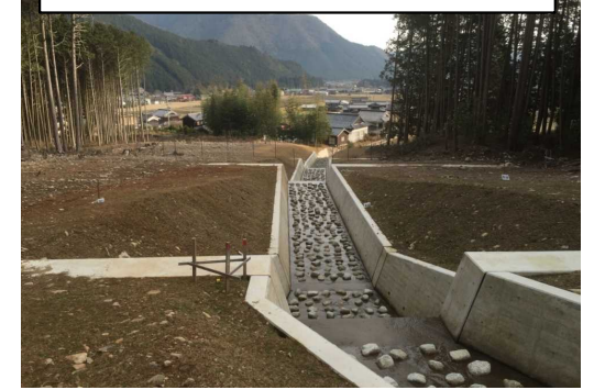
治山工事(流路工)
