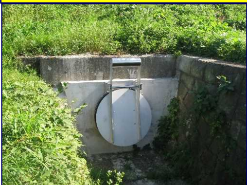
③ 樋門改良(加古川)
