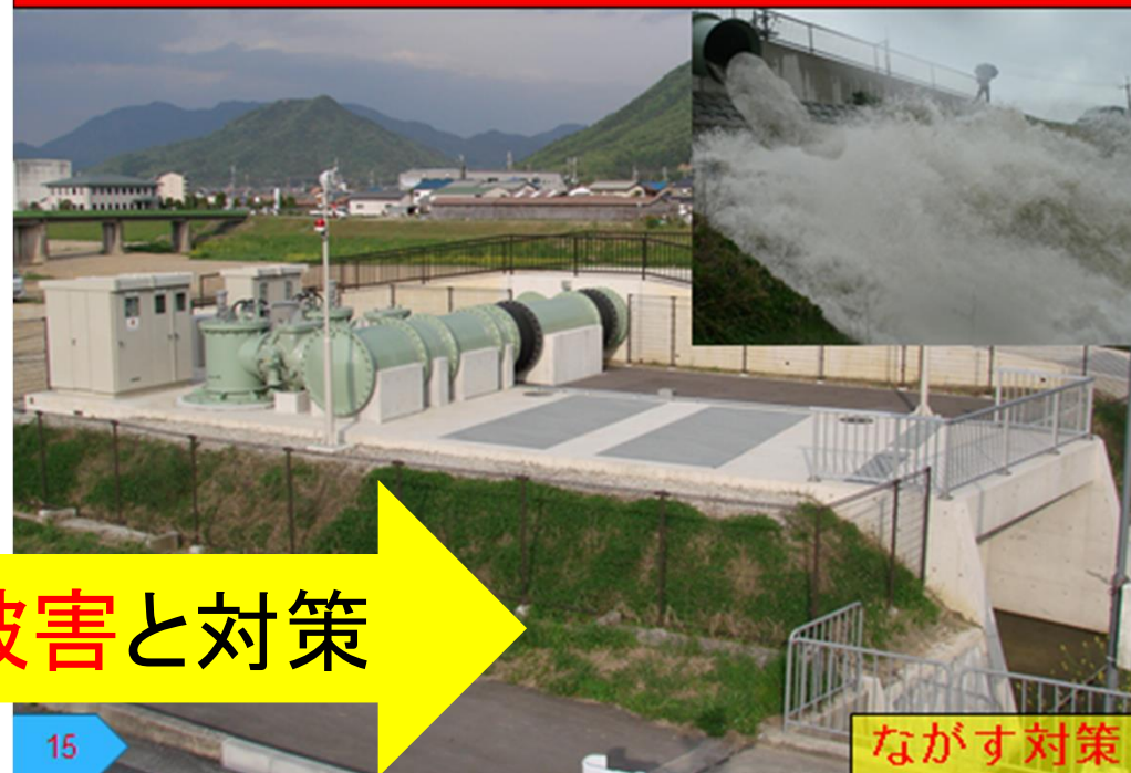
② その後の浸水対策 1 (ポンプ場雨水幹線整備)
