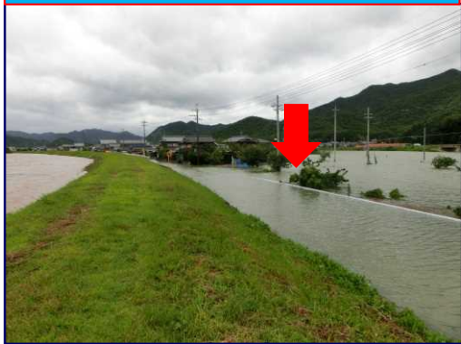
⑤ 雨水ポンプ場の建設
