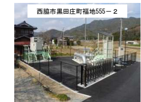
⑤福地雨水ポンプ場建設 (ポンプ φ250mm×2台 約15m 3 /分 水槽 約20m 3 (3.0m×4.2m×1.6m))
