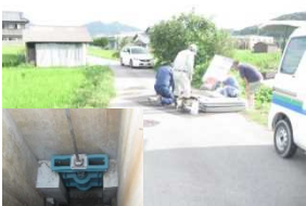
④樋門整備 (門柳川)
