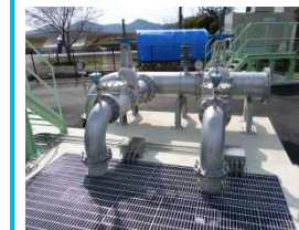
⑤福地雨水ポンプ場建設 (ポンプ φ250mm×2台 約15m 3 /分 水槽 約20m 3 (3.0m×4.2m×1.6m))
