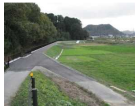
②福地川堤防嵩上
