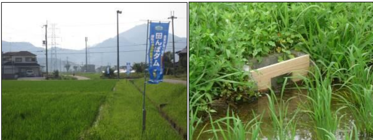
水田貯留の例（「田んぼダム」左写真：加古川市 右写真：小野市）
