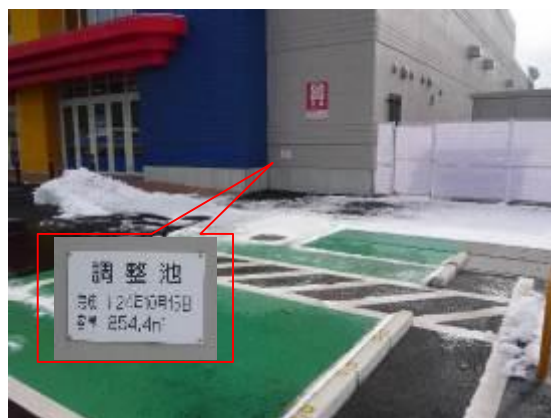
ケーズデンキ氷上店（丹波市）の 地下雨水貯留槽
