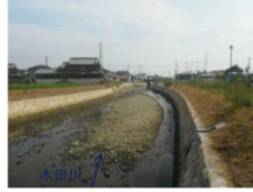
改修後の状況
