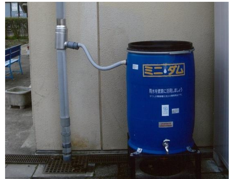
各戸貯留(雨水タンク)
