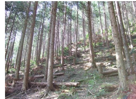
緊急防災林整備(土留工)
