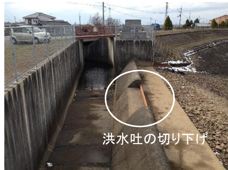
溝ヶ沢池の洪水吐切り下げ [稲美町での取り組み]
