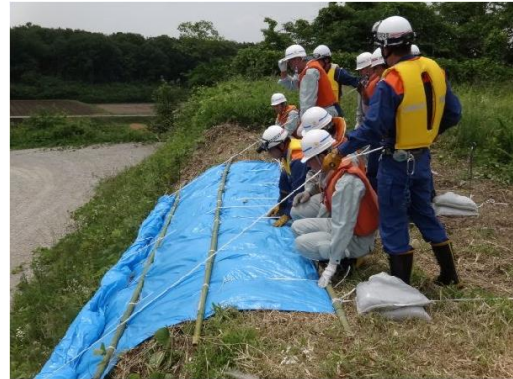
シート張り工法
