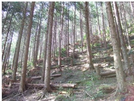
緊急防災林整備（土留工）
