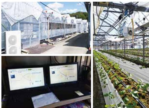
環境制御技術導入ハウス外観(左上)、ハウス内上部に設置された環境モニタリング機器(右)とモニタリング結果のモニター画面(左下)(神戸市北区)
