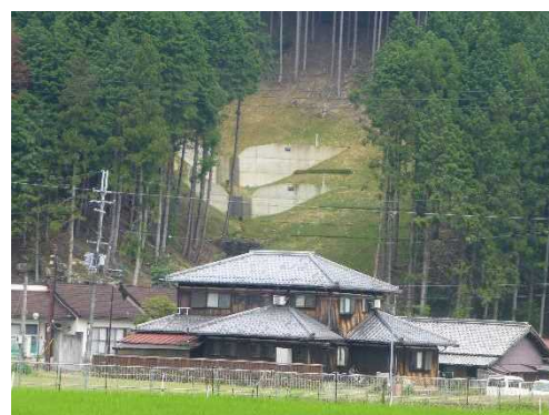
集落を守る治山ダム（多可町）
