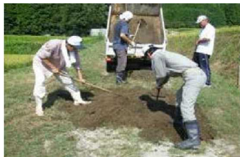
道路の補修（多可町）
