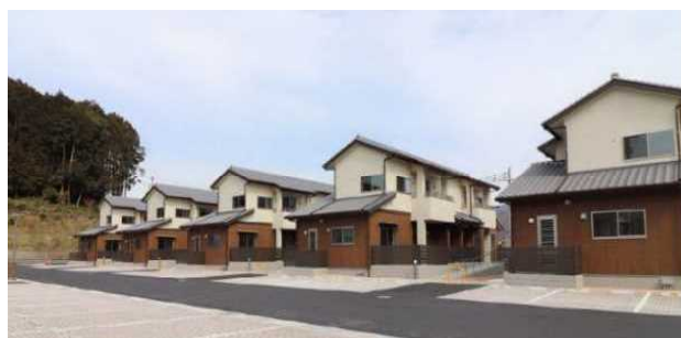
使用木材の9割に町内産を活用した木造住宅（神河町） ※高強度仕口（TajimaTAPOS）加工
