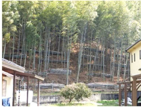
災害に強い森づくり[里山防災林整備] 一人家裏山の危険木等伐採— (姫路市)
