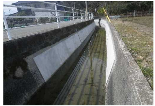
補修した水路（赤穂市）
