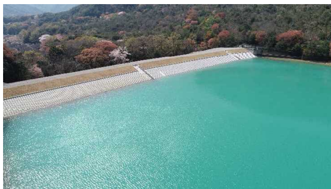
ため池改修（赤穂市湯の内池）
